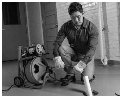
10-сурет – Ағын құбырын кабель шығысының 2' (0,6 м) шегіне созу үлгісі
