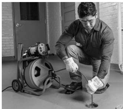
Figure 13 – En position de travail, avancement manuel du câble
