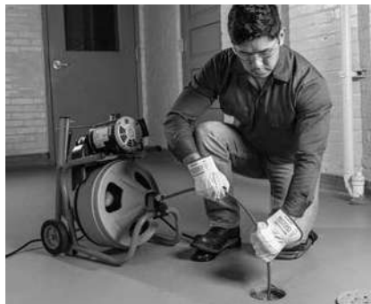
Figura 13 – In Posizione operativa, Inserimento manuale del cavo
