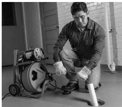
Figure 10 – Exemple d'un fourreau amenant le câble exposé à moins de 2' (60 cm) du dégorgeoir
