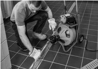
Figur 15 – Använda K-400 med AUTOFEED
