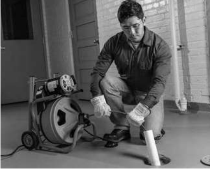
Figuur 10 – Voorbeeld voor het verlengen van de afvoer tot minder dan 2' (0,6 m) van de veeruitgang
