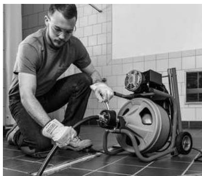
Figura 16 – Utilizar Máquina com Mangueira Guia
