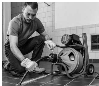
Slika 16 – Uporaba stroja z vodilno cevjo
