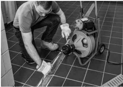
Slika 15 – Rad sa K-400 sa AUTOFEED
