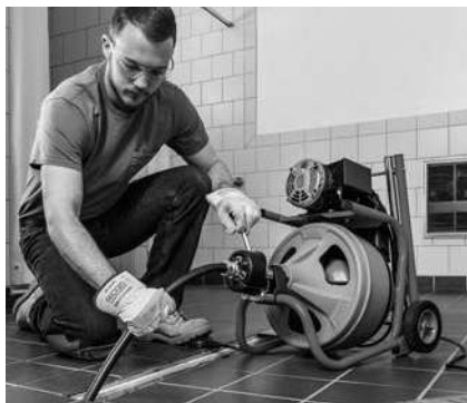
Εικόνα 16 – Χρήση του μηχανήματος με λαστιχένιο οδηγό
