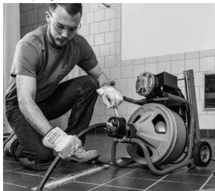
Figura 16 – Uso de la máquina con manguera-guía
