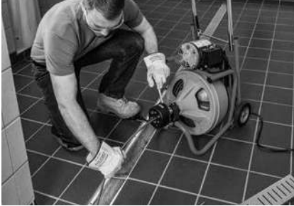
Şekil 15 – K-400 Çalıştırma AUTOFEED
