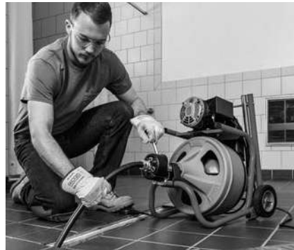
Figura 16 – Utilizarea mașinii cu furtun de ghidare
