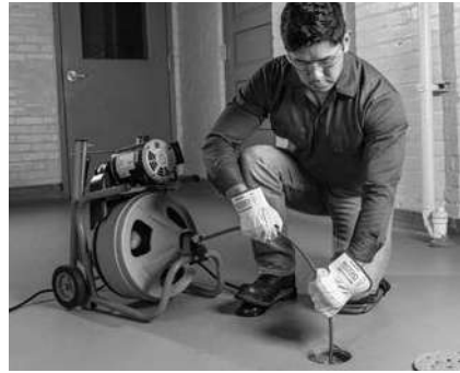
Figuur 13 – In de juiste werkhouding, de veer handmatig invoeren
